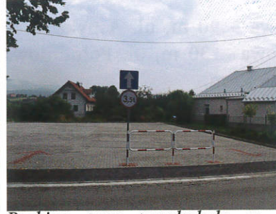
Parking przy przedszkolu w Łodygowicach Dolnych
