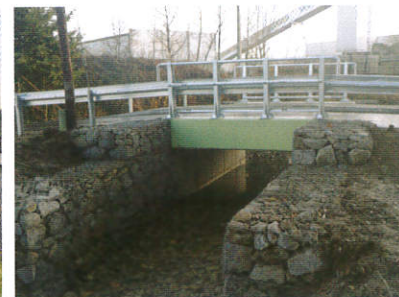
Przepust na ul. Łęgowej w Zarzeczcu
