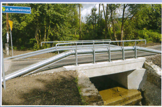
Most w ciągu ul. Rzemieślniczej
