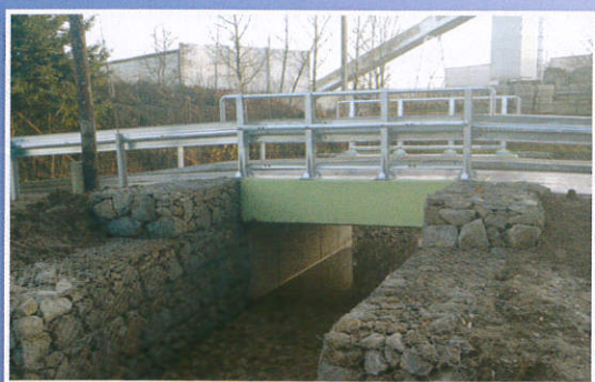
Przepust w ciągu ul. Łęgowej
