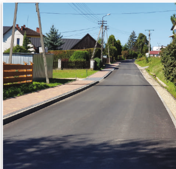
Ul. Kardynała Wyszyńskiego po remoncie
