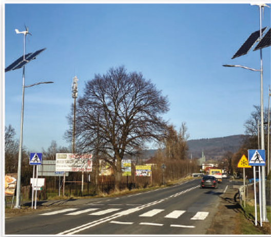
Przejście dla pieszych przy ul. Żywieckiej
