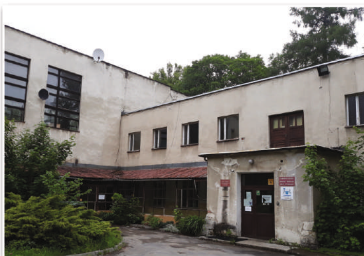
Oficyny zamkowe przed przebudową
