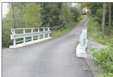
Most na ul. Żwirowej w Pietrzykowicach
