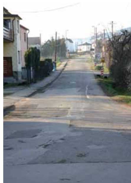
Ulica Batorego w Łodygowicach - w najbliższym czasie zostanie wyremontowana
