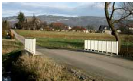
Łodygowice ul. Ceglana - nowy most na nowej drodze
