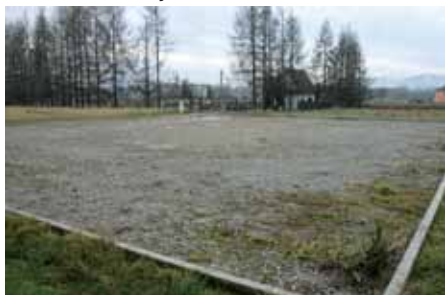
Budowa parkingu w Łodygowicach Górnych
