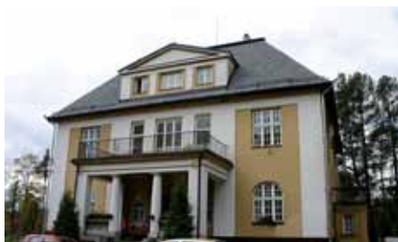
Wymiana pokrycia dachu w ZSS w Łodygowicach
