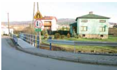
Skrzyżowanie ulic Piłsudskiego i Batorego - nowy chodnik i kładka
