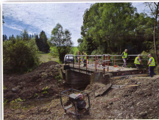
Remont mostu na ul. Na Stawach w Łodygowicach
