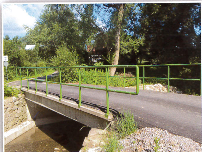
Most na ul. Szkolnej w Pietrzykowicach po remoncie
