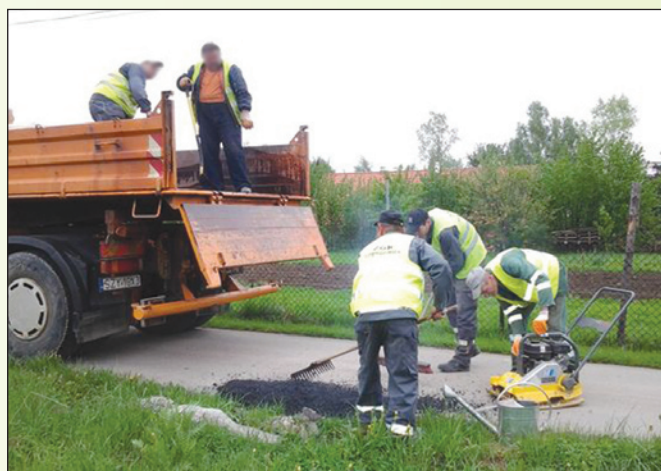
Usuwanie uszkodzeń pozimowych w Pietrzykowicach
