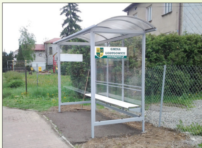
Montaż przystanku w Łodygowicach Górnych przez pracowników ZGK
